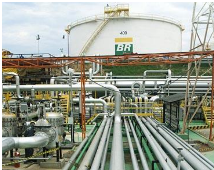
Oleoduto da Transpetro
